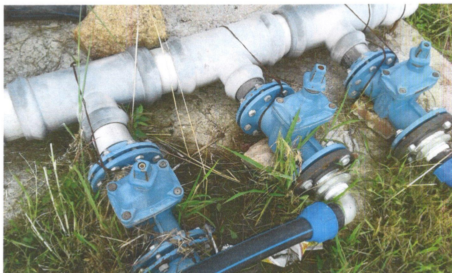
Colectores accesibles a ser operados por transeúntes, presentan perdidas las cuales son parcialmente contenidas por torniquetes de alambres
